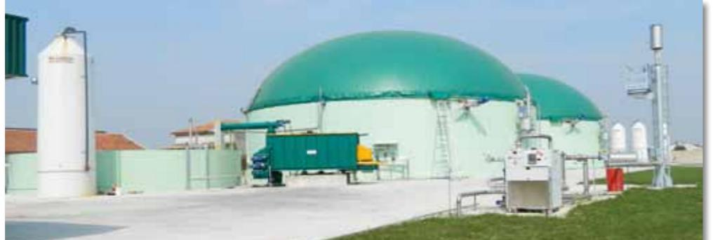
Soluzione con container costruito con appositi pannelli fonoassorbenti ed ignifugi. I freecooler di raffreddamento del motore sono collocati sopra il container.
