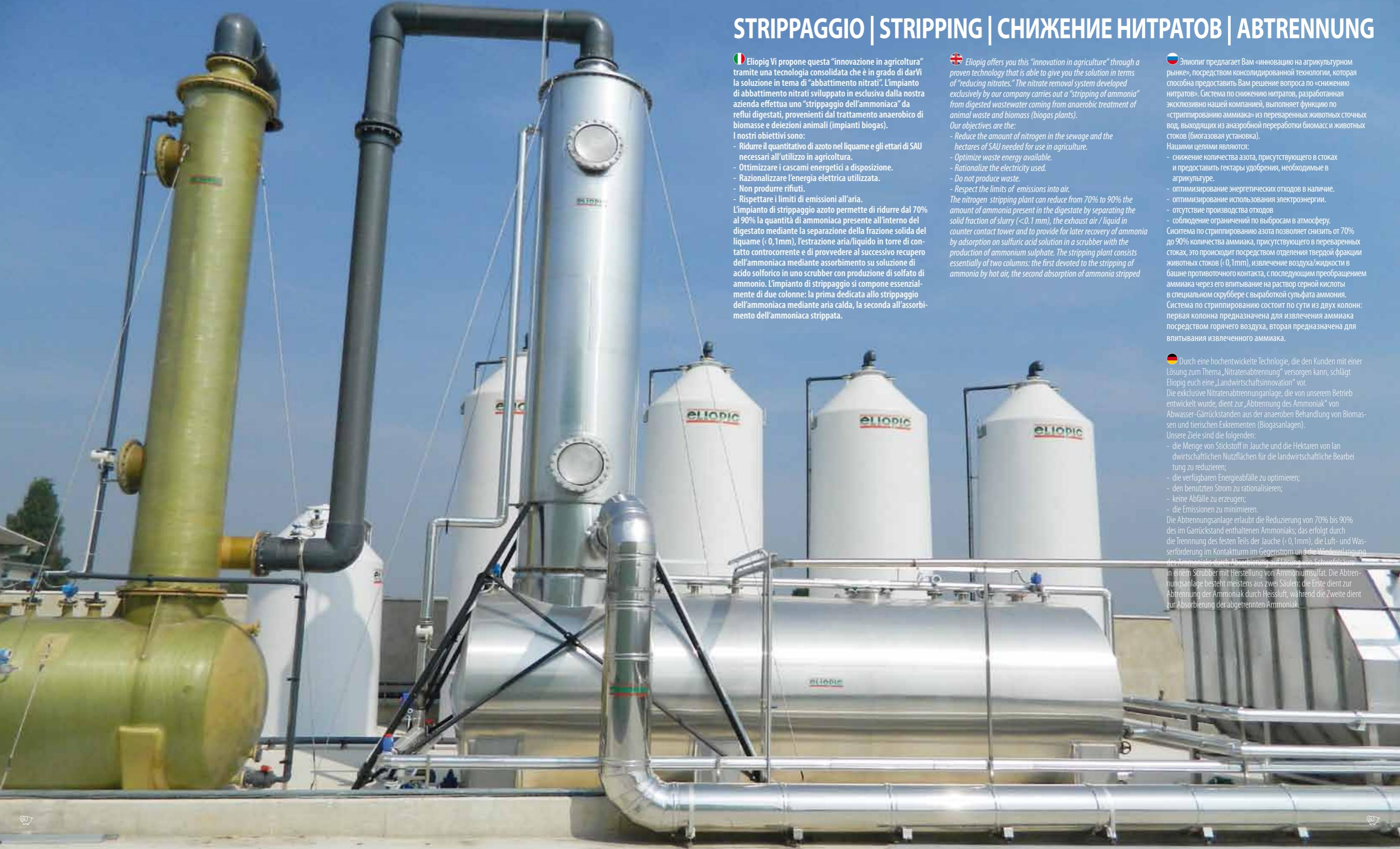
Eliopig Vi propone questa "innovazione in agricoltura" tramite una tecnologia consolidata che è in grado di darVi la soluzione in tema di "abbattimento nitrati". L'impianto di abbattimento nitrati sviluppato esclusivamente dalla nostra azienda effettua uno "strippaggio dell'ammoniaca" da reflui digestati, provenienti dal trattamento anaerobico di biomasse e deiezioni animali (impianti biogas).
