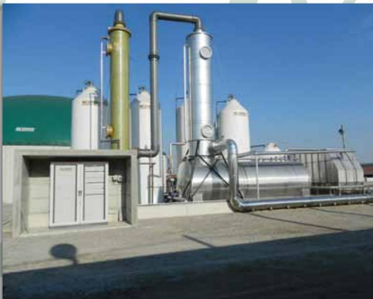
L'impianto di strappaggio Eliopig è composto da due colonne: la prima dedicata allo strappaggio dell'ammoniaca mediante aria calda, la seconda all'assorbimento dell'ammoniaca strappata. A completamento del sistema vengono forniti i silos di stoccaggio del reagente (acido solforico) e quelli per lo stoccaggio del prodotto derivante dal processo (solfato ammoniacale).
