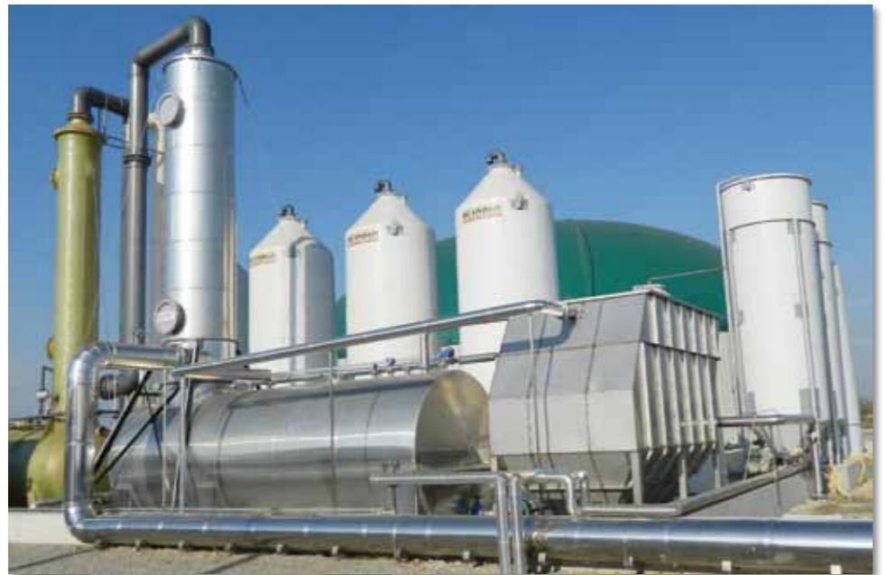
Nell'immagine è possibile vedere un sistema di strappaggio a valle di un impianto Biogas da 500 kWe alimentato da diezioni prodotte da un allevamento suinicolo. È possibile notare sul lato destro il sedimentatore, ovvero il sistema che permette di rimuovere eventuali corpi solidi sospesi presenti nella frazione liquida in arrivo dal separatore.
