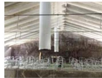
In figura viene mostrato il flusso dell'aria all'interno del capannone proveniente dalle finestre ed estratto dai camini. Il vantaggio consiste nella possibilità di regolare, in modo preciso e automatico, le portate di ricambio indipendentemente dalle condizioni climatiche esterne.
