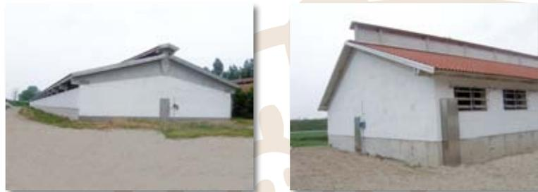
L'impianto di ventilazione naturale sopra illustrato mostra un flusso d'aria naturale, entrante dalle finestre ed espulso dai cupolini. La portata d'aria e' massima quando si ha un delta di temperatura più alto tra l'interno e l'esterno del capannone.
