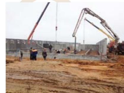
In questa tavola viene mostrata una delle prime fasi della realizzazione del cantiere edile, dove vengono costruite le fondamentazioni e posati i pannelli.
